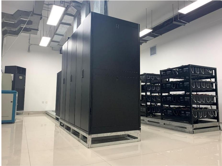
图3-3 A级标准建设的数据中心机房配电室
